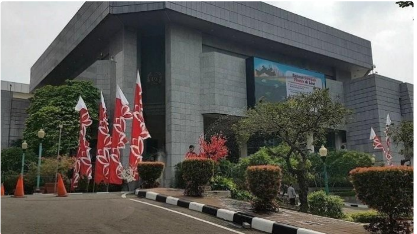
Gedung DPRD DKI Jakarta Jl.Kebon Sirih, Jakarta Pusat
